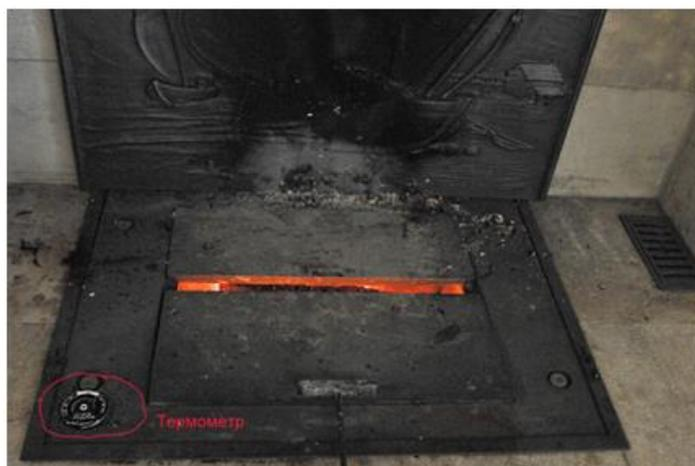
Наиболее эффективного горения добиваются с помощью термометра, измеряющего температуру верхней чугунной плиты. На термометре выделен белый сектор от 200 до 300 градусов. Когда стрелка термометра находится в этом секторе, сгорание топлива происходит наиболее полно.
