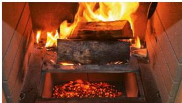
**Режим № 3.** Дрова горят и в нижней и в верхней топке. Также в помещение поступает лучистое тепло от огня, а нижняя топка работает как мощный и эффективный конвектор и обогревает воздух. Нижняя топка может быть настроена на режим длительного горения. КПД верхней топки до 20%, нижней - до 70-80%.
